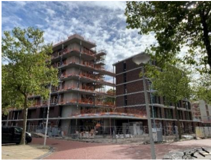
Foto 1 Sloopnieuwbouwproject in Nieuw-West
