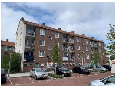
Foto 3 Recent gerenoveerde woningen
